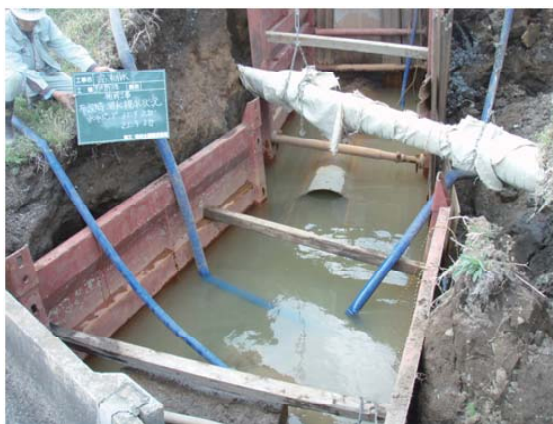
破損したパイプラインの応急工事状況 (茨城県笠間市)
