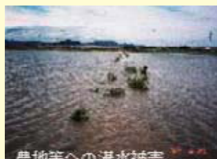
農地等への湛水被害
