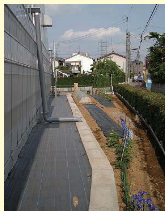
排水施設整備
