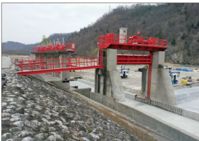
頭首工(整備後)
