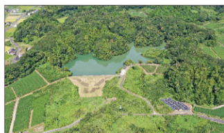
池ヶ谷池ドローンによる全景
