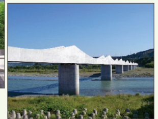
大井川水路橋
