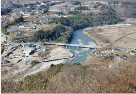
仮締切状況(河川下流側より)
