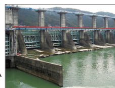
取水施設(船明ダム)
