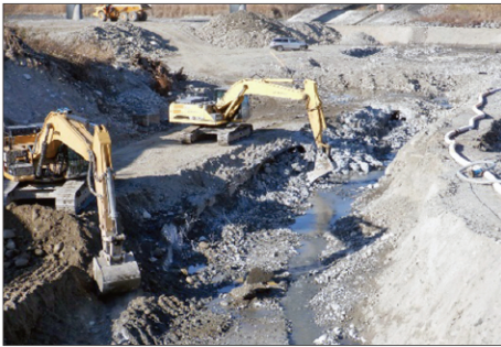
伏越撤去状況
