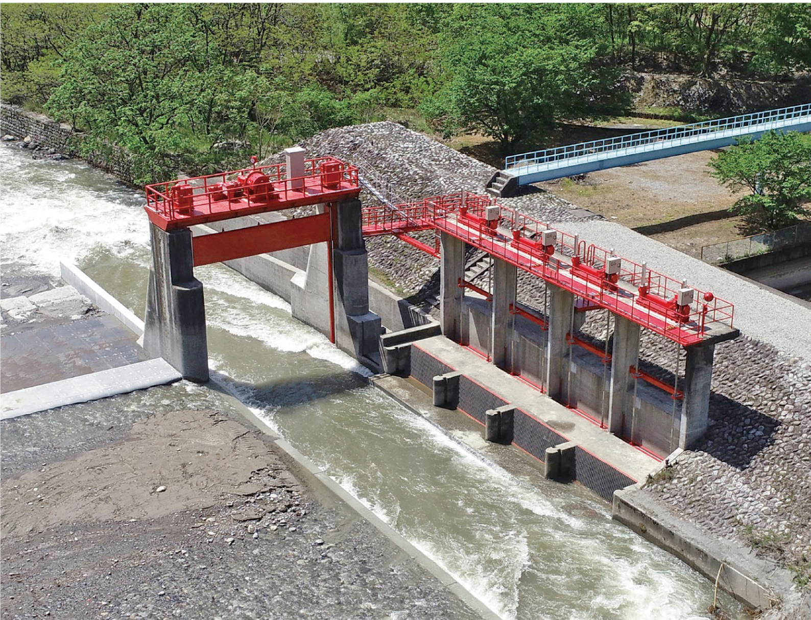
徳島頭首工(釜無川地区)
