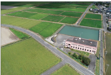
浅羽揚水機場 全景
