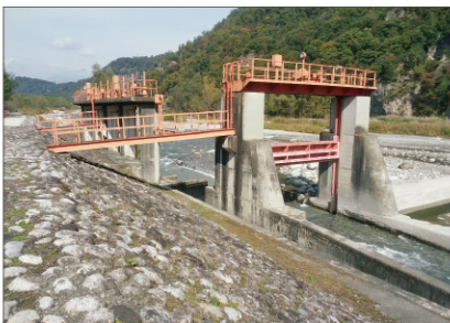
頭首工(整備前)
