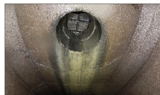
斜樋内部ドローン撮影写真
