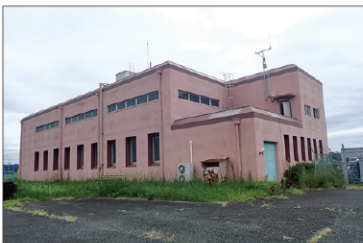
既設機場建屋
