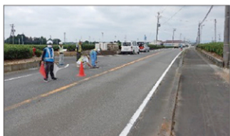
空気弁調査状況
