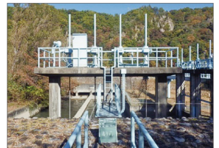
ゲート(整備前)
