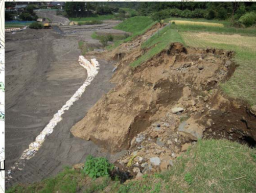
水田の流失及び法面の崩壊
