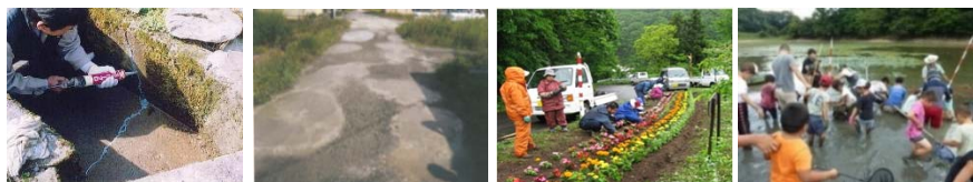
水路のひび割れ補修 農道の窪みの補修 植栽活動 ため池の外来種駆除
