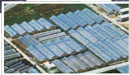
区画整理後に導入されたハウス
