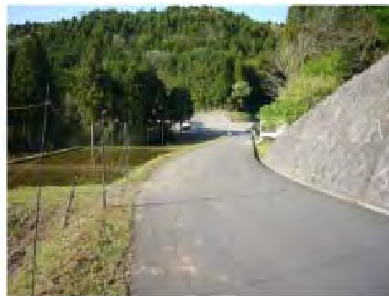
整備された農道
