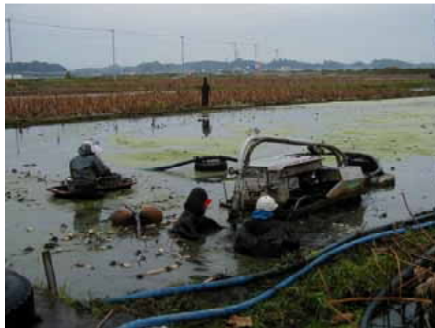
<写真part 2> 掘取機ほり丸使用状況
