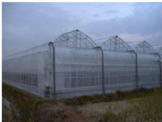
<写真 4> 高軒高ハウス
