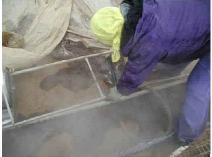
熱水土壤消毒の作業状況
