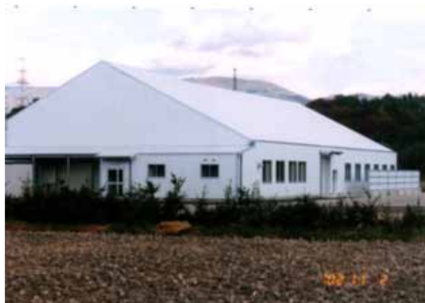
集出荷選別施設
