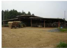
1 整備された畜舎【茨城中央地区】
