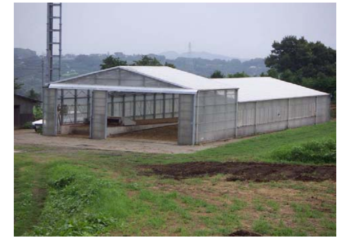
⑧整備された家畜排せつ物処理施設【二宮地区】
