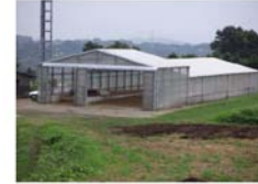
10 整備された家畜排せつ物処理施設【二宮地区】
