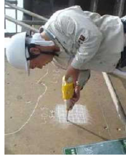
老朽化した施設の機能診断
