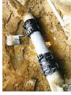
漏水防止のための整備
