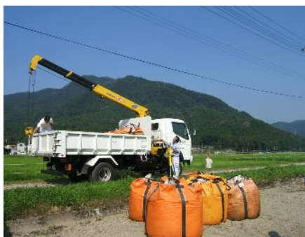
写真「フレコンバッグ搬入作業」
