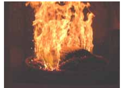
ボイラー内での燃焼の様子
