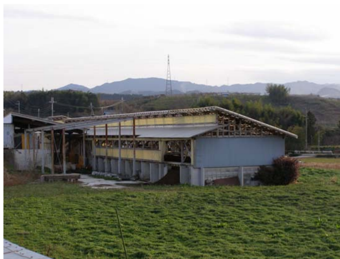
たい肥生産施設
