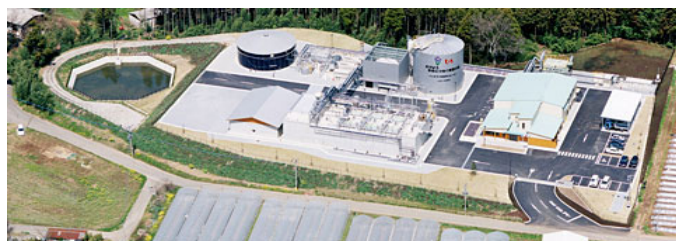
○日田市バイオマス資源化センター
