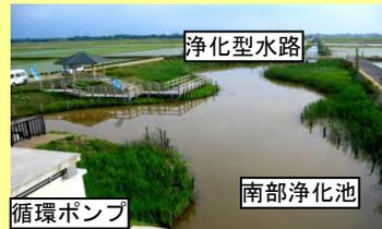
排水は浄化型水路に流入し、浄化池から循環ポンプで再び農業用水として利用。
