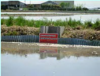
地域全体で各筆の排水口に止水板を設置し、濁水の流出を抑制。約280箇所設置。
