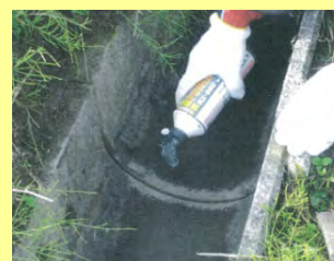
用水路の目地補修
