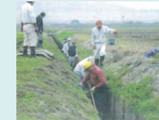
濁水防止のための水路溝畔等の補強
