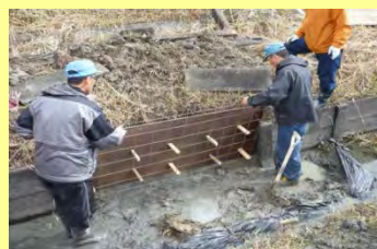
排水路の側壁の補修 （現場打ち水路の直営施工）
