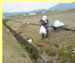
排水路の補修 （土のうによる補強）
