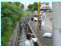
路肩・法面の草刈り
