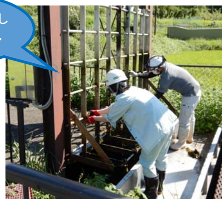
現場業務の様子 (除塵施設の清掃)
