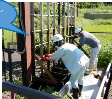
現場業務の様子 (除塵施設の清掃)
