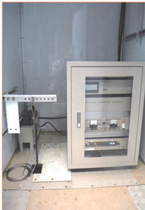
ダム上流及びダム下流の水位を管理所で集中監視し、貯水位、流入量計測や洪水時等急激な水位変化のデータ収集を行います。令和2年度に、上流及び下流の3局について、機器を更新しました。
