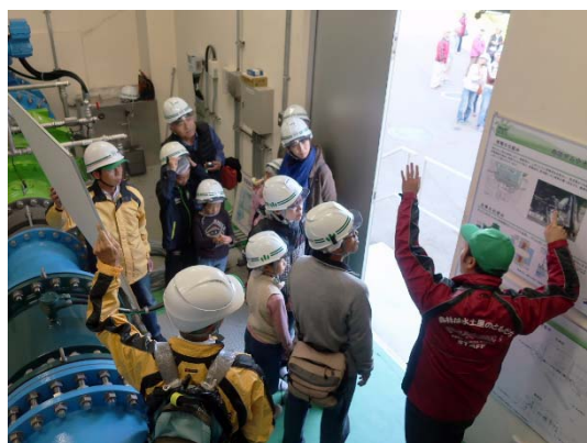
小水力発電施設
