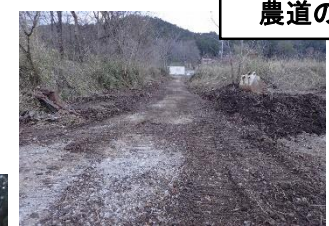
排水路の復旧
