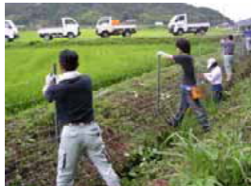
【防護柵の設置】
