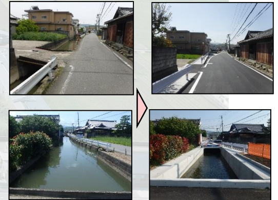
米田排水路 (第2工区)
