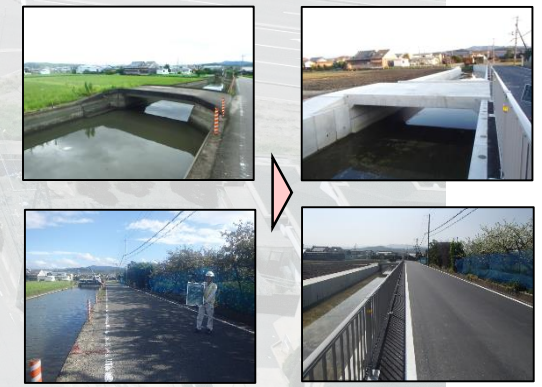
米田排水路 (第1工区)
