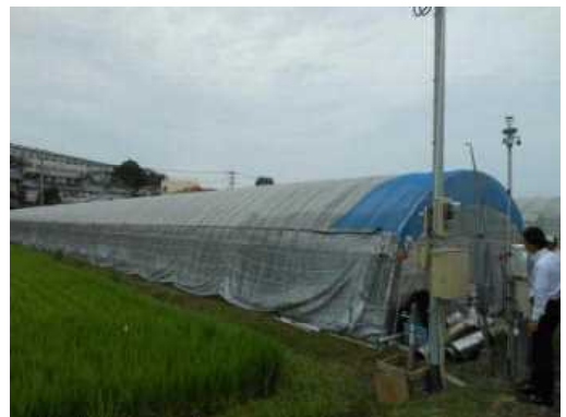
▽ 新品の半分の経費で建設されたハウス
