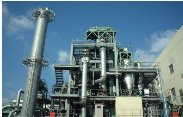
汚泥溶融処理施設（中部下水処理場）
