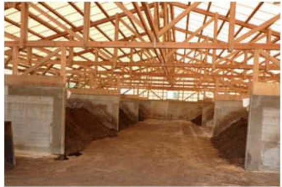
写真 11 五島灘酒造(株)堆肥化施設内部
