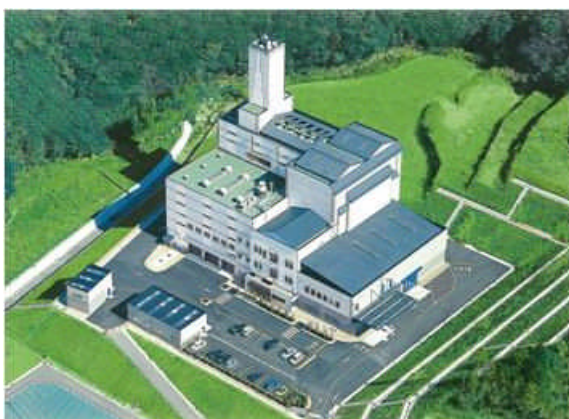
写真4 焼却施設全景
