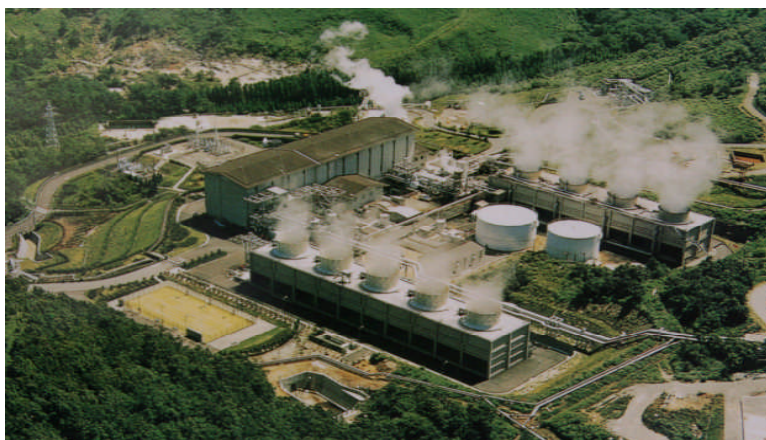
八丁原発電所
