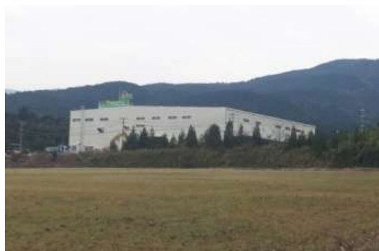
建設中の木質ペレット工場(小林市)
