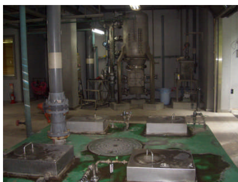
図 16 衛生センター (内観)
