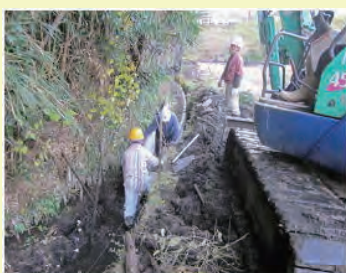
施工中（水路布設状況）
