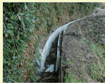
施工後（コンクリート水路）
