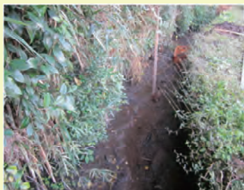
施工前（土水路）
