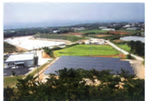
県営畑地帯総合整備事業「池当地区」 （鹿児島県和泊町）の太陽光パネル
