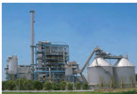
みやざきバイオマスリサイクル発電所
