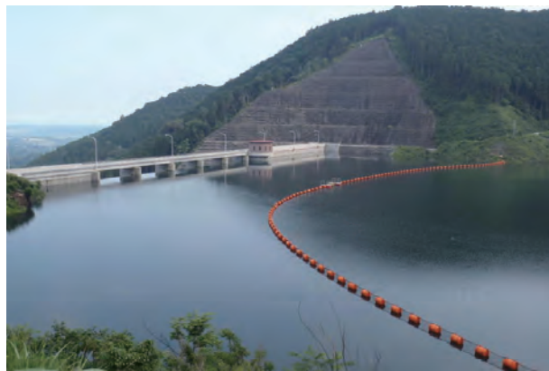
きりばる 切原ダム湛水状況写真
