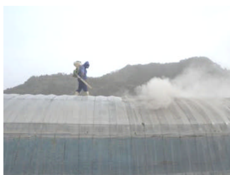
ブローアによるハウスの灰除去作業
