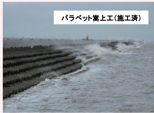
パラペット（波返）施工完了後
