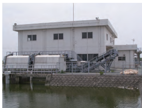
整備された排水機場（福岡県筑後川下流地区）
