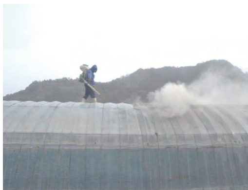
ブロアーによるハウスの灰除去作業
