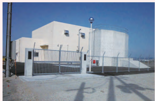
平成24年に改修された大和第1排水機場
