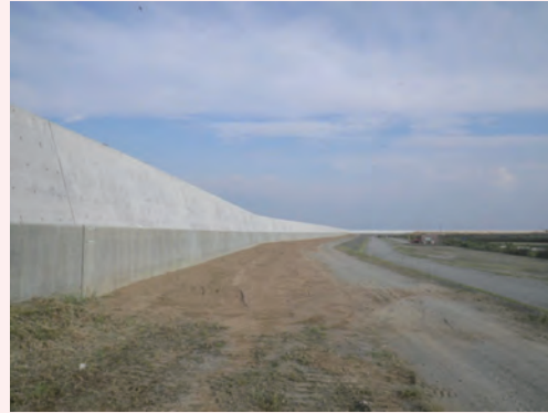
パラペット（波返）施工完了後
