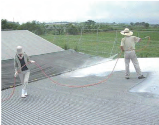
畜舎屋根への石灰乳の塗布（宮崎県西都市）
