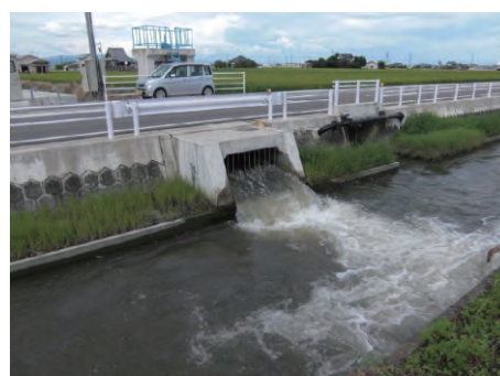
嘉瀬川からの導水による地区内水路への補水状況
