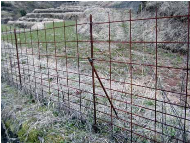
防護柵の設置状況
