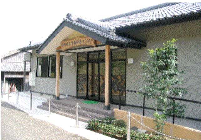
完成した田代地区営農研修センター
