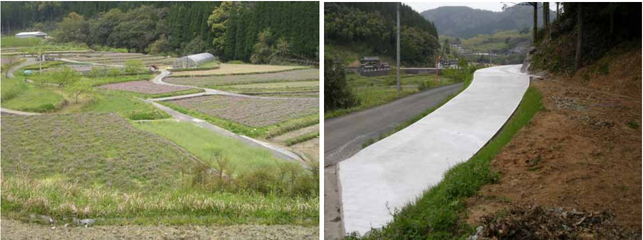
集落の直営施行により管理道路の舗装・拡幅工事が完了
