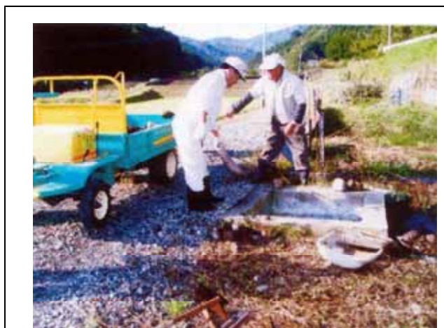
台風で土石が詰まった水路の復旧作業
