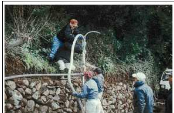
農業用水ホースの交換、石垣の整備
