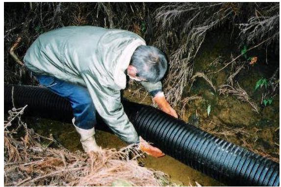
素掘り水路へのパイプ設置
