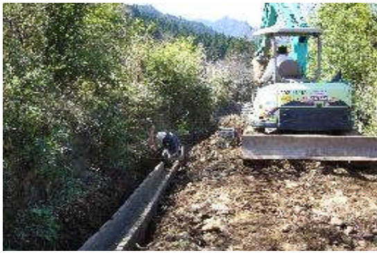
水路布施替え作業
