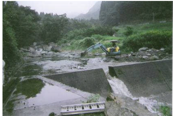
頭首工管理作業
