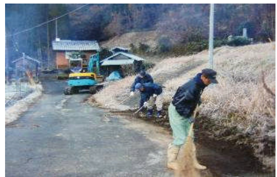
農道土砂除去作業
