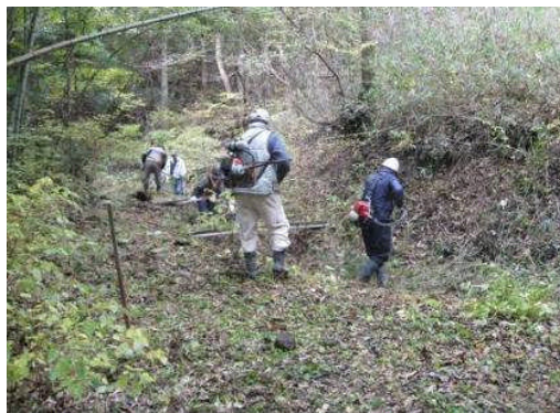
水路草刈り作業
