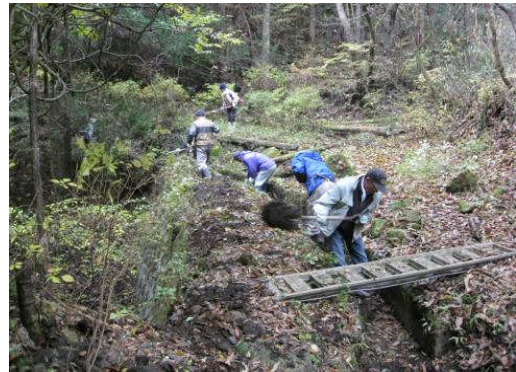
水路泥上げ清掃作業
