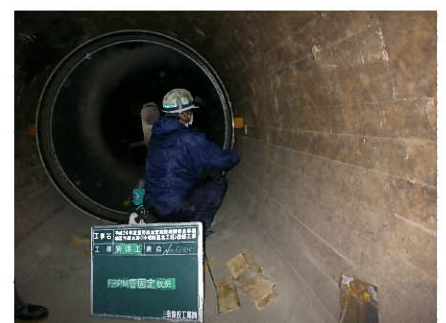
10号隧道補強工事の施工状況
