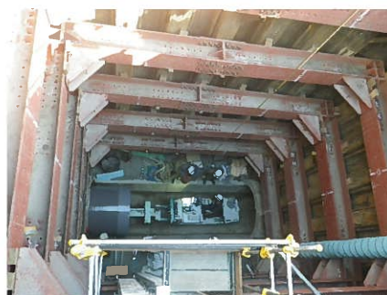
10号隧道補強工事の施工状況
