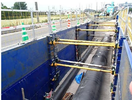
幹線水路更新工事の施工状況 (φ900, φ350の複合配管)
