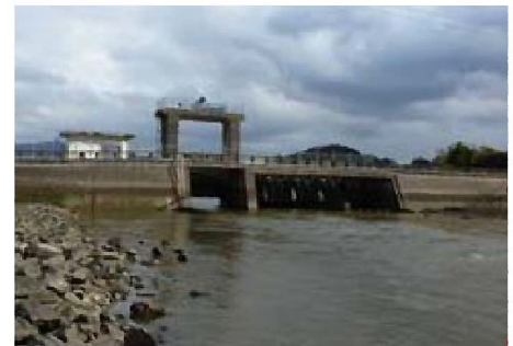
清水頭首工 （堰長62.8m、土砂吐ゲート1門、フラップゲート5門）
