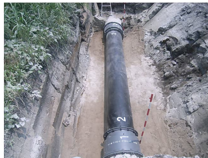
幹線水路漏水復旧状況
