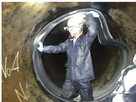
PC管（止水バンド工法による復旧）
