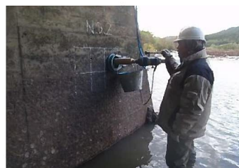
コア削孔状況
