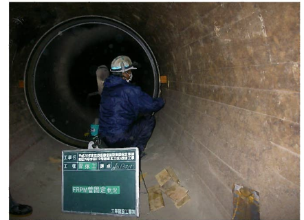
10号隧道補強工事の施工状況
