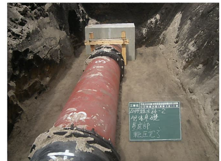
幹線水路漏水復旧状況
