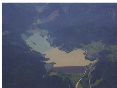
ダムへの濁水流入状況 （平成17年 台風14号通過直後）
