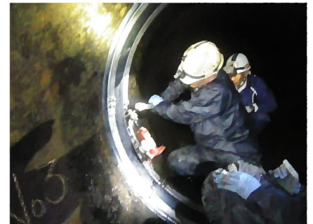
止水バンド工法による漏水復旧状況
