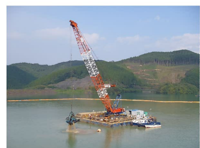
選択放流施設基礎掘削工 クレーン付台船による浚渫状況（H29.10）
