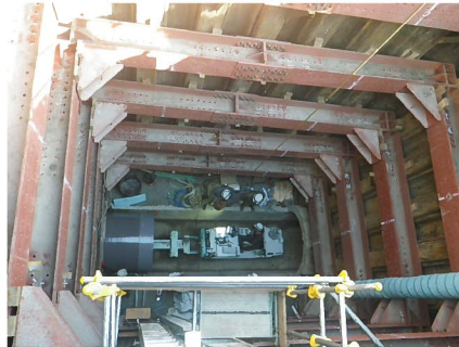
10号隧道補強工事の施工状況
