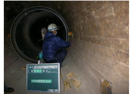
10号隧道補強工事の施工状況
