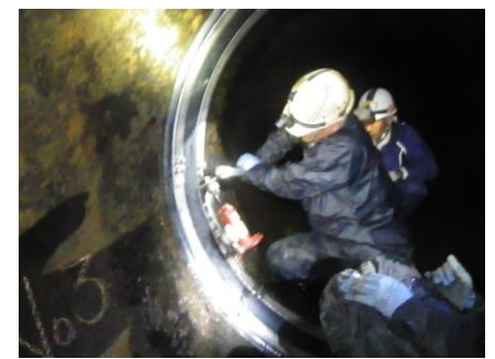
止水バンド工法による漏水復旧状況
