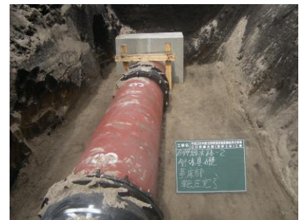
幹線水路漏水復旧状況
