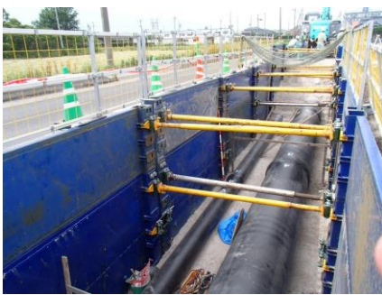
幹線水路更新工事の施工状況 (φ900, φ350の複合配管)
