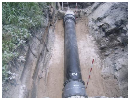
幹線水路漏水復旧状況
