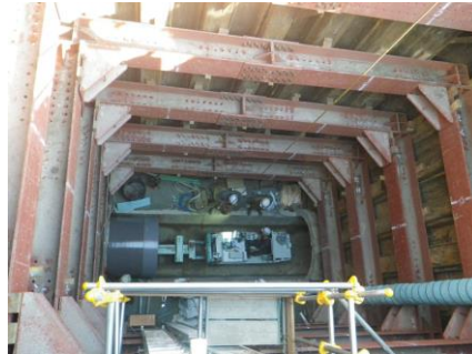
10号隧道補強工事の施工状況
