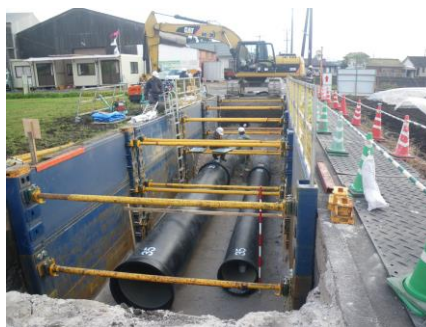
幹線水路更新工事の施工状況 (φ900, φ600の複合配管)
