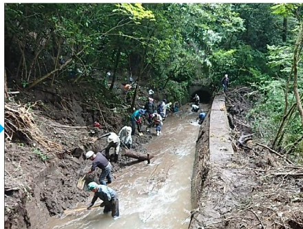
崩落土砂上げ作業状況 (被災箇所①)
