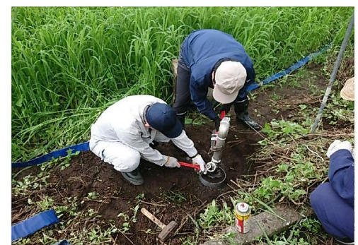
仮廻し配管接続部作業状況
