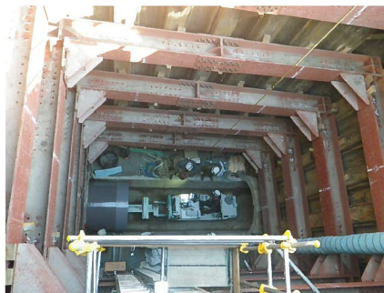
10号隧道補強工事の施工状況
