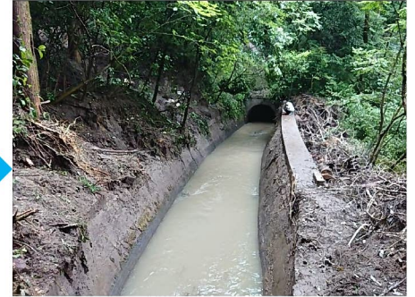
応急復旧後通水状況 (被災箇所①)
