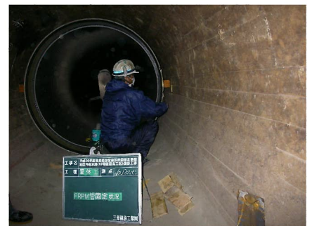
10号隧道補強工事の施工状況
