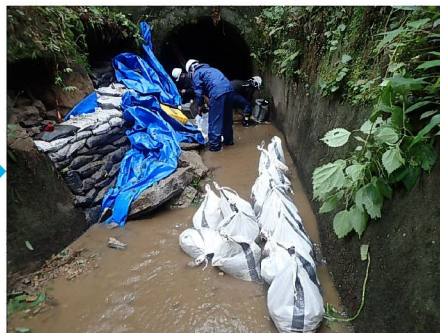
水路側壁応急復旧作業状況 (被災箇所②)
