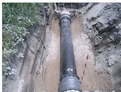
幹線水路漏水復旧状況
