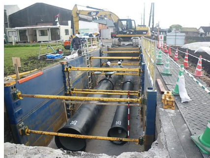
幹線水路更新工事の施工状況 (φ900, φ600の複合配管)
