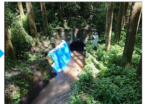
応急復旧後通水状況 (被災箇所②)
