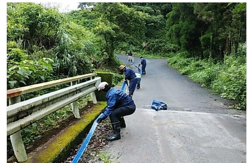
仮廻し配管作業状況
