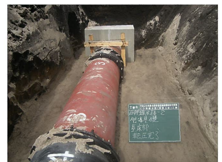
幹線水路漏水復旧状況
