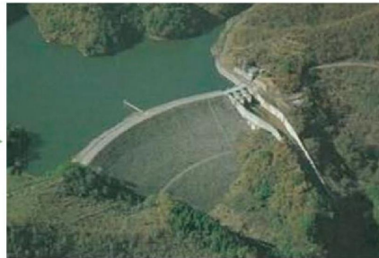
▲水源を安定確保(日出生ダム)
