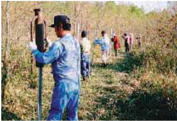
牧柱立て 牧柱は4m間隔で設置
