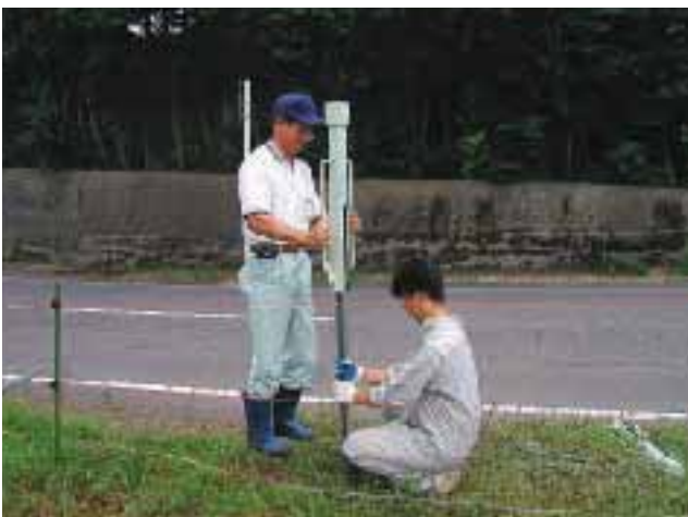
フェンス支柱の打ちこみ
