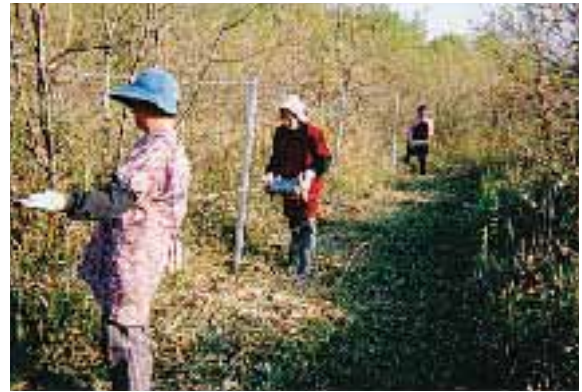
有刺鉄線張り 有刺鉄線は4段張り
