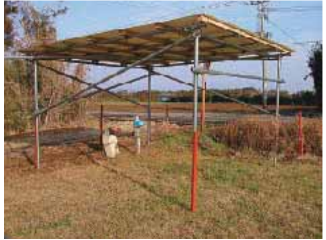
庇陰施設 単管パイプと畜産波板を活用して簡易に作成できます。
