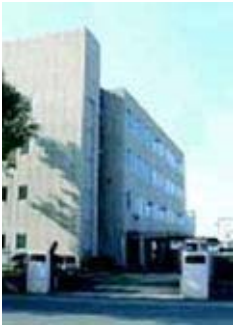
土地改良技術事務所
